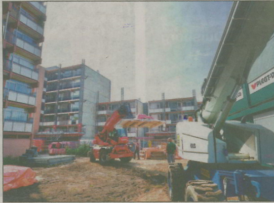
■ Zestig tot tachtig bouwvakkers zijn dagelijks bezig in de flats in de Weenhof.
