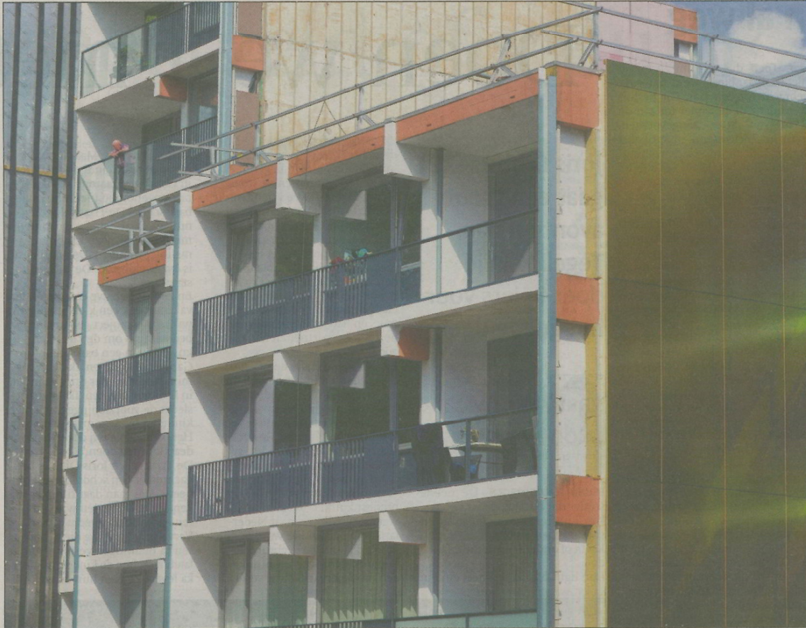
■ Een aantal flats is al opgeknapt, met een nieuwe glazen pui en een balkon met glazen doorkijk. De zalmroze gevelwand is vervangen door nieuwe beplating die van kleur verandert, afhankelijk van de lichtinval. foto Do Visser
